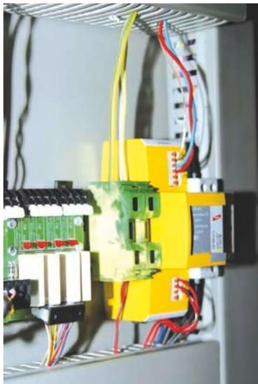
Abb.5: DEHNvario – Kombi-Ableiter für den Schutz elektroakustischer Anlagen
