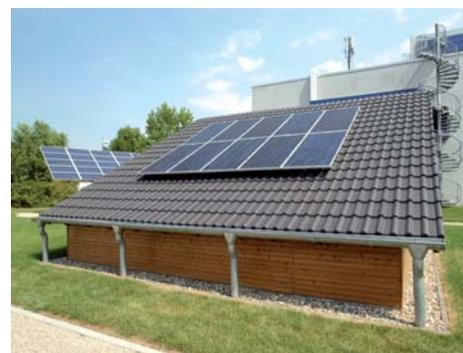
Abb.2 Dachparallele Lehrpfad, Aufbau mit 2-lagigem Montagegestell
