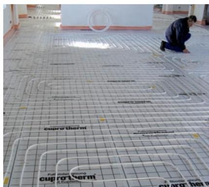
Abb.2 Verlegung einer Fußbodenheizung im Bahnhof Plön
