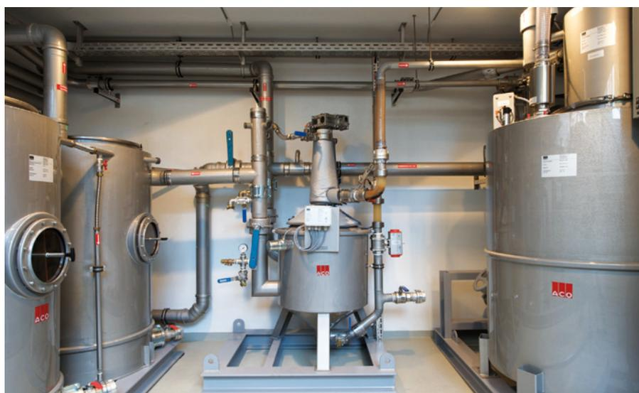
Abb.2: Die Fettabscheideranlage mit Nassmüllentsorgung und biologischer Nachbehandlung in Segmentbauweise von ACO Haustechnik
