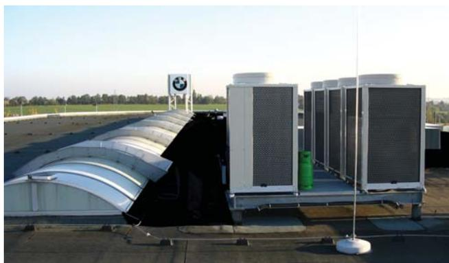
Abb.5 Auf dem Dach montierte VRF-Einheiten
