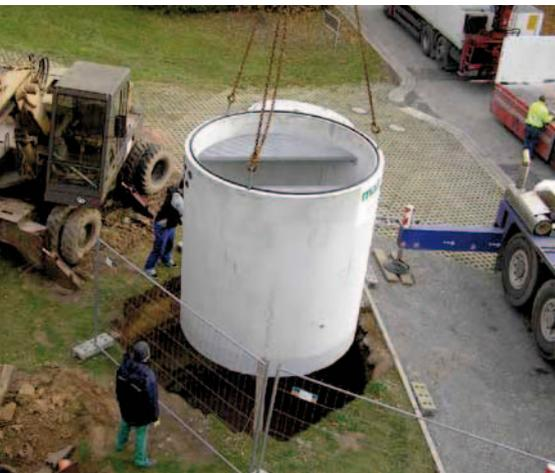
Abb.4: Einbringung der Betonhülle eines erdvergrabenen Pufferspeichers.
