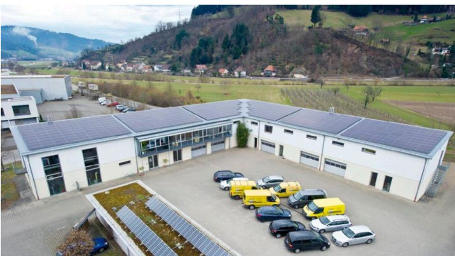
Abb. 3: 100 kWp-Dachanlage mit neuem S-Class Vision Modul bei Fa. Kammerer Luft- und Wärmetechnik im Schwarzwald (Werkbild Centrosolar)
