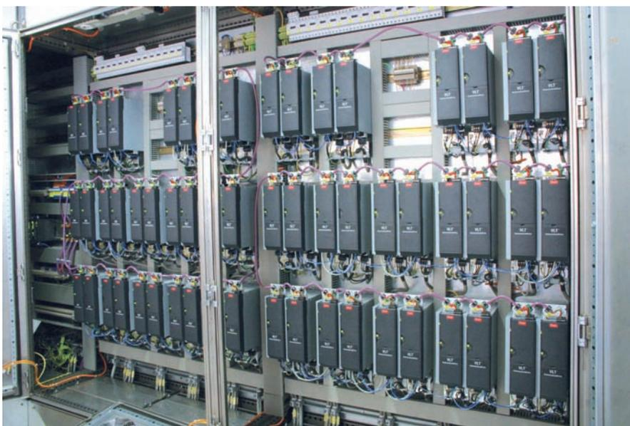
Abb.7: In großen Anlagen sorgen viele hundert Frequenzumrichter für eine reibungslose Steuerung der Produktionslinien
