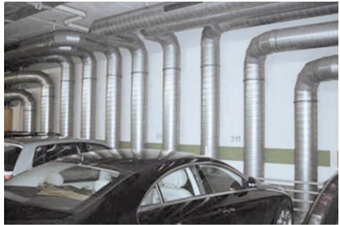
Abb. 2: Abluftrohre in einer Tiefgarage
