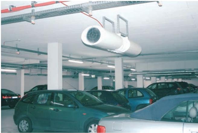
Abb. 1: Jet-Ventilator in der Tiefgarage der Europazentrale von Hyundai in Offenbach/Main
