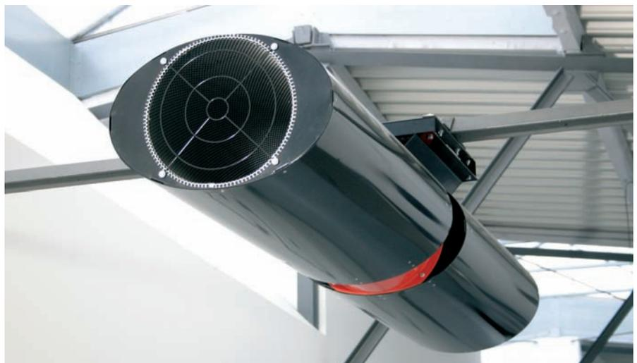
Abb. 12: Jet-Ventilator mit ovalen Ansaug- und Ausblassechalldämpfern; TLT-Turbo GmbH, Bad Hersfeld
