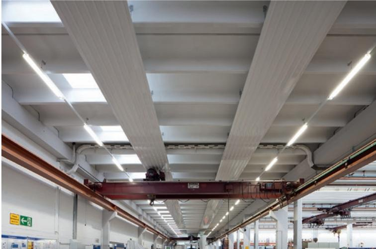
Abb.3: Gleichmäßige Wärme in allen Hallenbereichen: Durch die Funktion der Deckenstrahlplatten nach dem Strahlungsprinzip herrscht in der Halle überall eine zugluftfreie, behagliche und vor allem konstante Temperatur. Das ist nicht nur angenehm für die Belegschaft, sondern auch förderlich für Präzisionsarbeiten, etwa an den Maschinenbauteilen.
